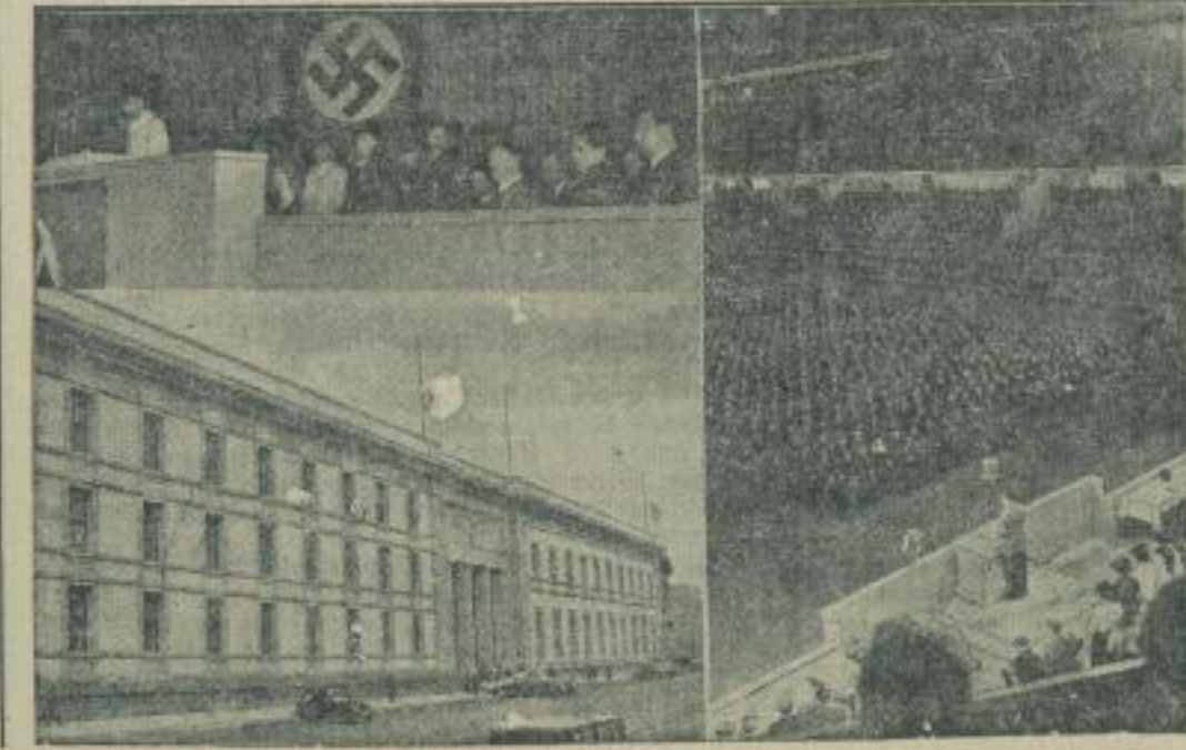
Die feierliche Uebergabe des neuen Reichskanzlei. Mit 8000 am Bau beteiligten Arbeitern feierte der Führer im Berliner Sportpalast die Fertigstellung der neuen Reichskanzlei. Oben links: ein Berliner Arbeiter begrüßt den Führer im Namen der Arbeiterschaft. Darunter: Der Neubau der Reichskanzlei in der Hofstraße. — Rechts: Der Führer spricht zu den Arbeitern und dankt ihnen für ihr Werk. (Zeitbild-Bagenberg-W.)
