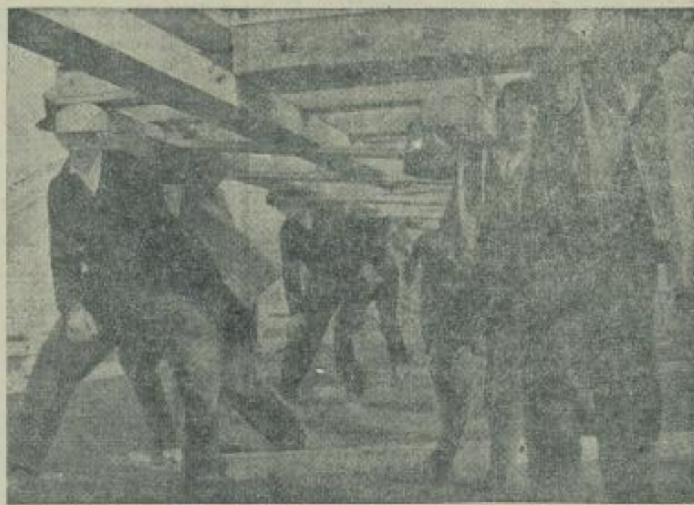
Ein großer Binder wird aufgerichtet.
