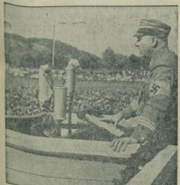
Die große Rundgebung am Westwall. Generalinspektor Dr. Todt während seiner großen Rede auf dem Bauweg der Westwall in Trier. (Welfbild-Wagenborg-W.)
