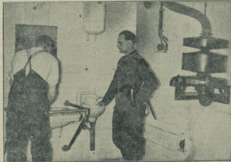
wird. — Unsere Aufnahmen von den deutschen Westbefestigungen zeigen: Links Mannschaftsabteilung an einem Kampfwert am Westwall. — Rechts: Wackelstube, Warmwasserspeicher und Entlastungsvorrichtungen in einem Kampfwert. (Welsbild-Wagenborg — M.)
