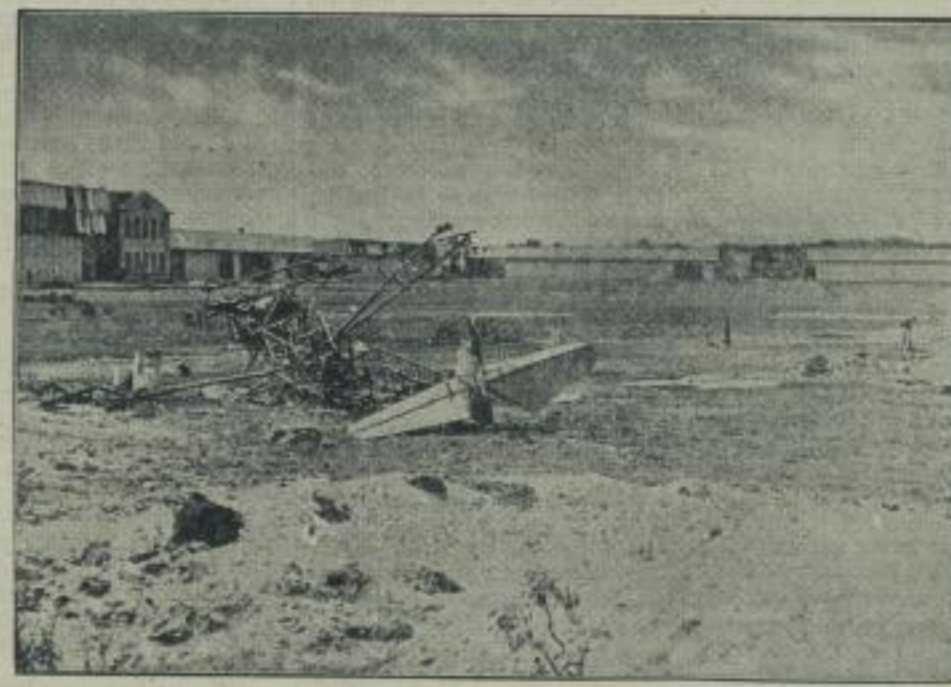
Unsere Luftwaffe zielt sicher! Das beweist einmal mehr dieses Bild des Flugplatzes in Thorn nach seiner Bombardierung durch die deutsche Luftwaffe in den ersten Tagen des Einmarsches. Nicht nur zahlreiche Flugzeuge gingen in Flammen auf, auch das Rollfeld wurde durch die Einschlagskrater (im Vordergrund) unbrauchbar gemacht. Im Hintergrund erkennt man an den hohen gleichfalls stark Beschädigungen (H. Wankel-Sch.-Wagenberg-W.)
