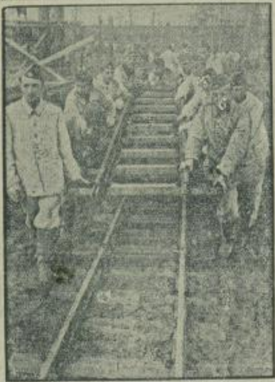
Wieder Aufbau im Wartlager.
