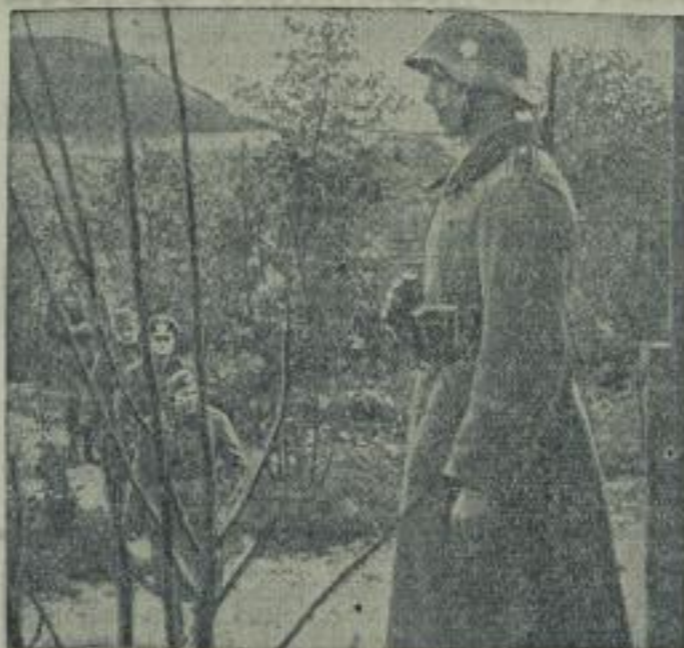
Auf der Wacht im Westwall. Posten vor einem Bunkerzugang im Westwall. (Hr. Scherl-Wagenborg-M.)
