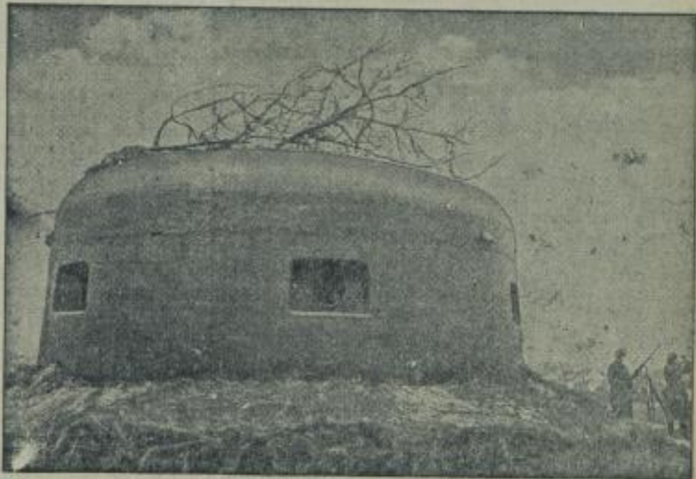
Eine Panzertappele am Weisau. Jede Bodenhebung des Westwalls, die eine Beobachtung des Geländes gestattet, ist mit einem solchen Acker aus Stahl und Beton getarnt. In ihm sind die Beobachter und die W.K. Schützen. (Dr.-Tritschler-Scherl-Wagenborg M.)
