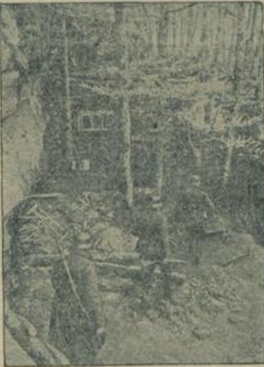
Auf der Wacht an der Westfront. In einer Bergkuppel im Westen haben sich die Vorposten ein stabiles Blockhaus errichtet, das ihnen Schutz gegen Schnee und Kälte bietet.
