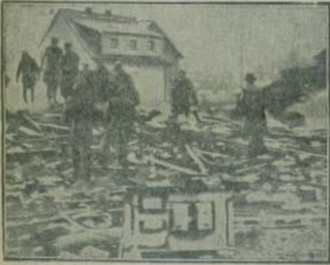
Am Schauplatz der Gasexplosion von Pleittemberg.
