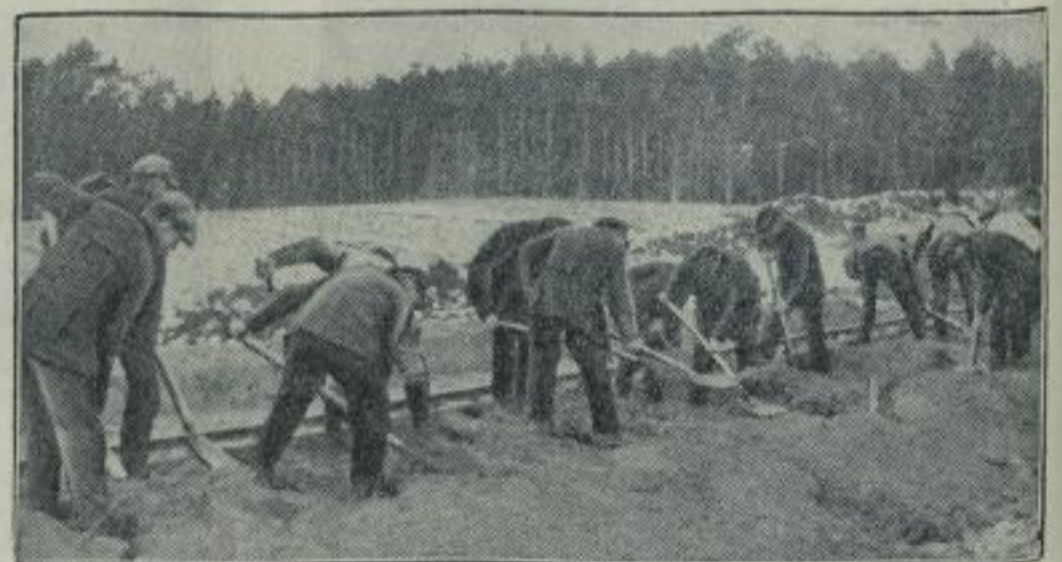
Vom Bau der Reichsautobahn Berlin-Stettin.
