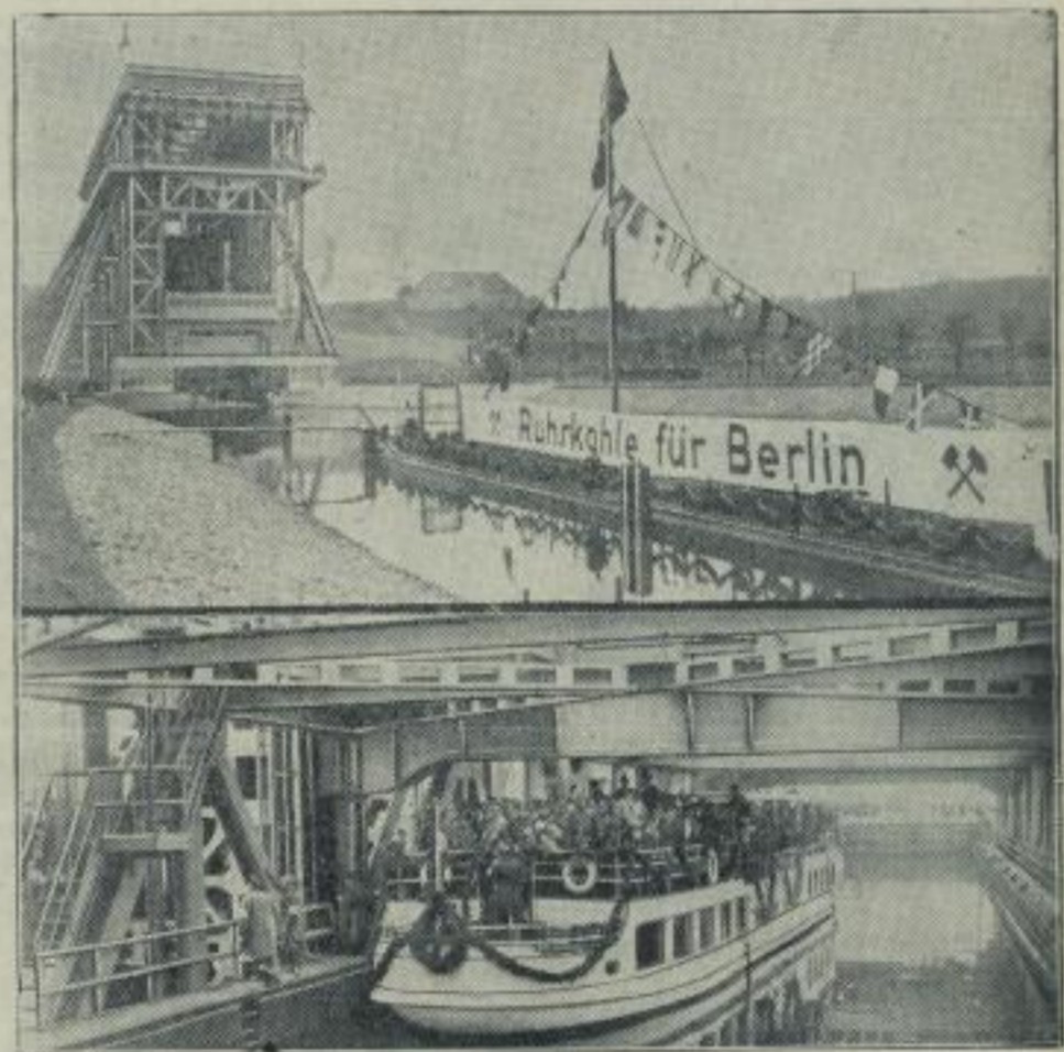
Die ersten Durchschleifungen durch das Schiffshebewerk Niedersinnow.
