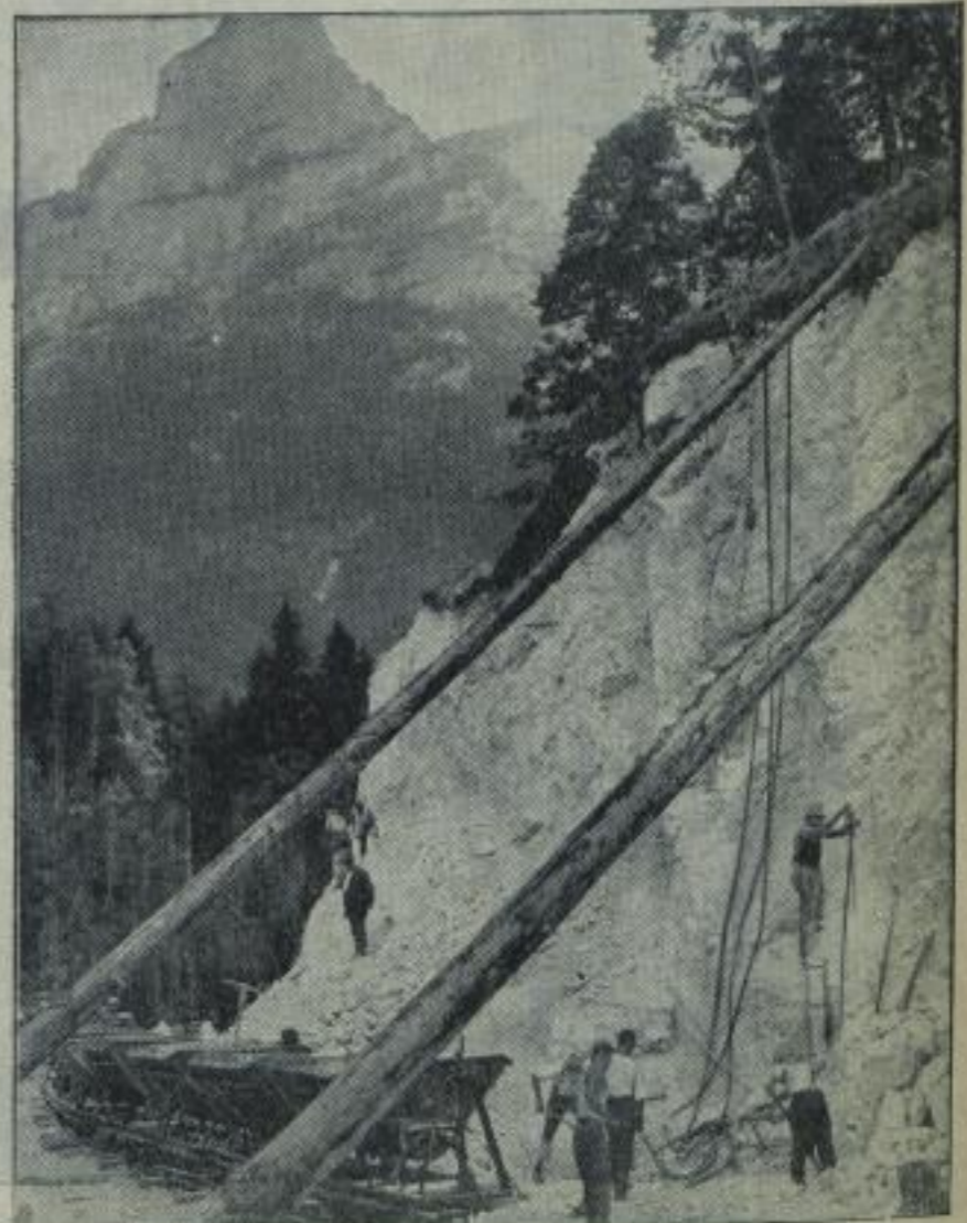
Das Aufbaumwerk; die neue deutsche Alpenstraße im Bau. Bohrungsarbeiten an der neuen Queralpenstraße, die durch die engen Felsentäler des Perchtoldsdorfer Landes führt.
