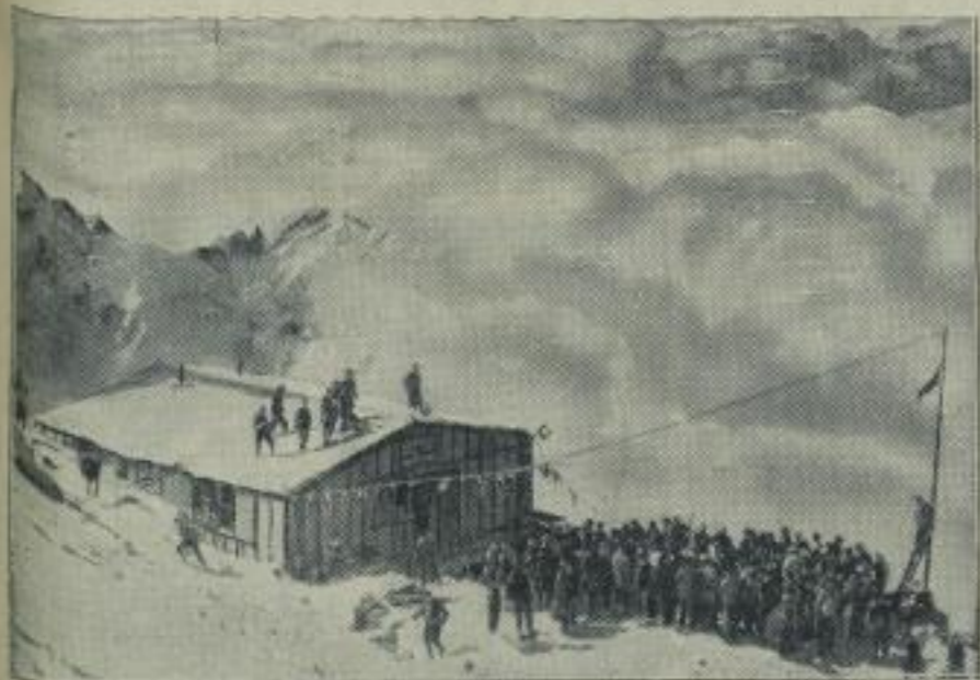
Die höchste Schutzhütte der Alpen auf dem Montblanc geweiht. In 3167 Meter Höhe wurde auf dem Montblanc eine neue Schutzhütte ihrer Bestimmung übergeben. Unser Bild berichtet von der Einweihungsfeier dieser mit allen Bequemlichkeiten eingerichteten Schutzhütte inmitten der Alpenwelt.
