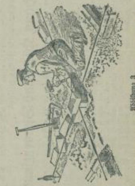
Abbildung 3 Befestigen der Wegeinrichtungen aus Handstein
