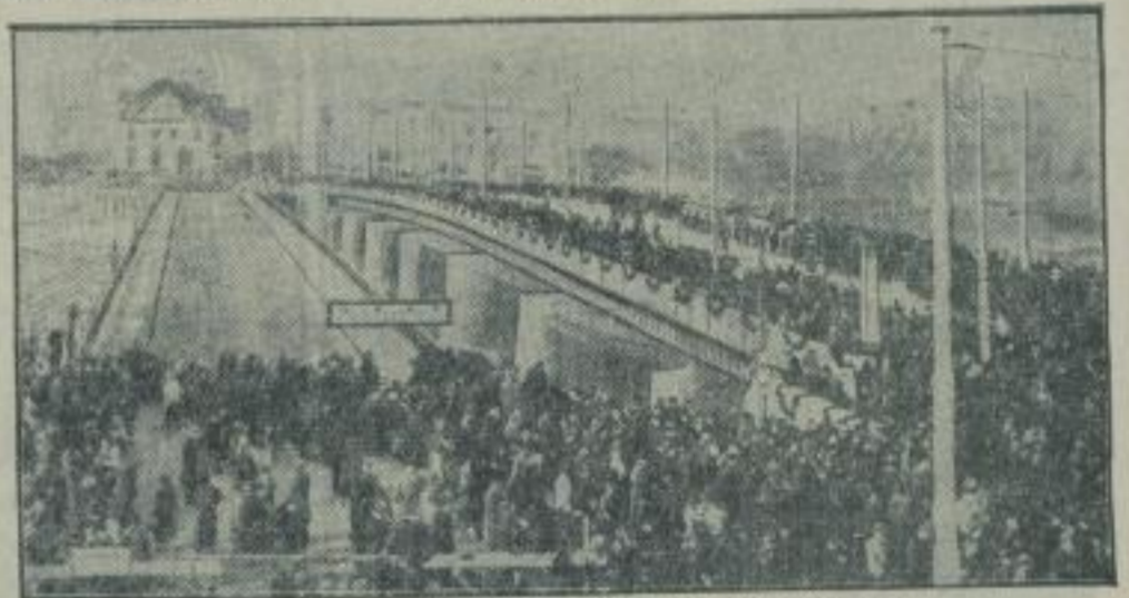
Die Einweihung der Magdeburger Pionierbrücke. Im Zuge der durch Magdeburg führenden Reichsverkehrsstraße wurde die „Brücke der Magdeburger Pioniere“, ein technisches und architektonisches Meisterwerk, in Anwesenheit der Magde- burger Bevölkerung feierlich eingeweiht. Reichsstatthalter Los- per und Reichsarbeitsminister Seibert waren an der Spitze zahl- reicher Ehrengäste erschienen. Das Bild gibt einen Blick auf die alte Holzbrücke (links) und die neue Steinbrücke (rechts), die eine wesentliche Erleichterung für den Kraftverkehr bedeutet.
