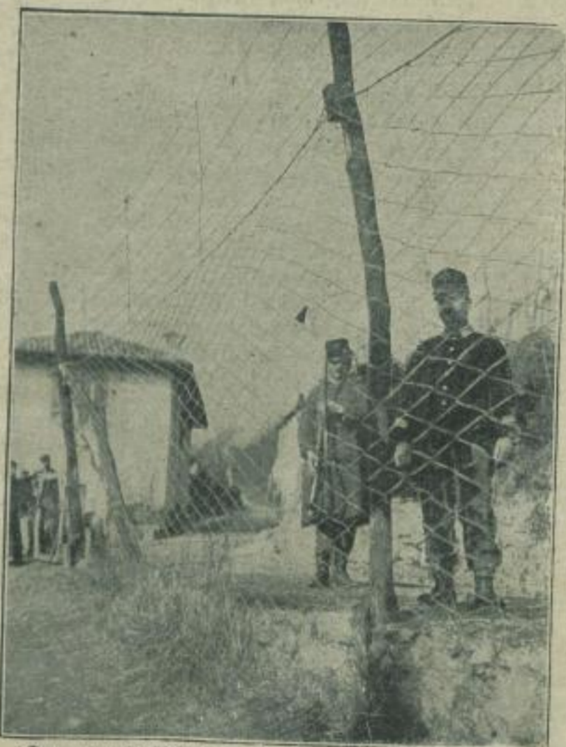
Der neue Zollschutz an der Grenze zwischen Italien und der Schweiz (4 m hoher Drahtzaun).
