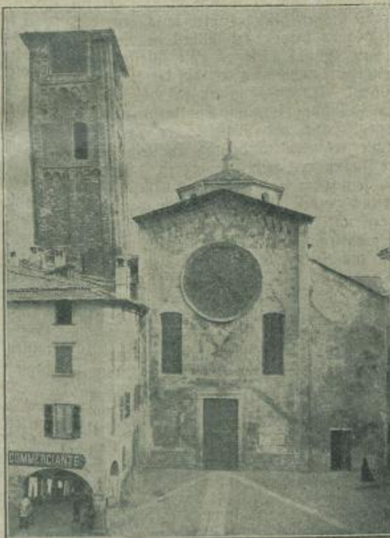
Die Kirche San Fedele in Como. (Wird jetzt wegen Bauverfalligkeit abgebrochen.)
