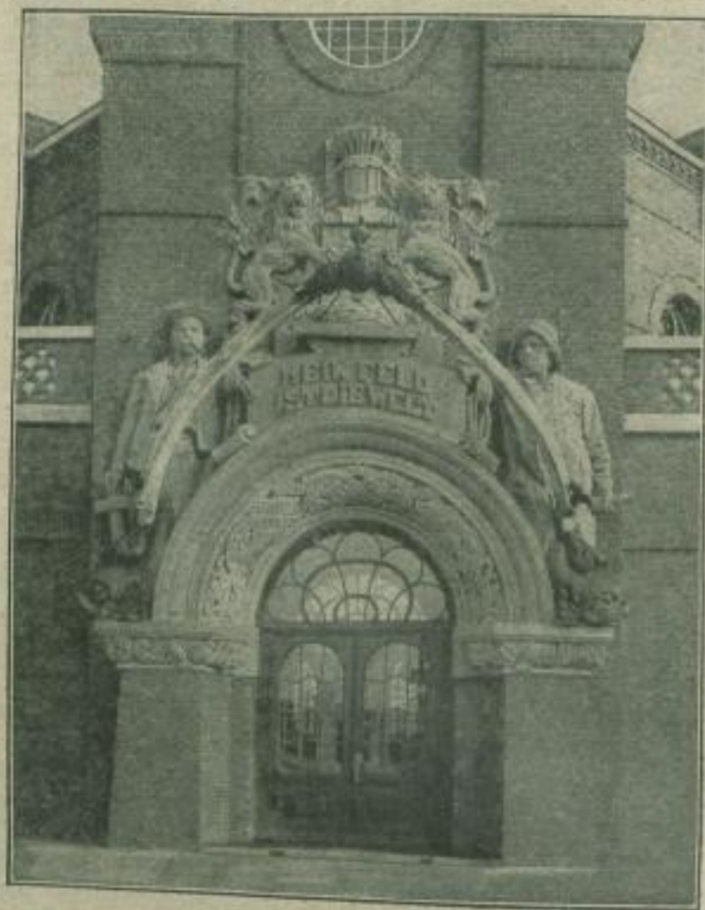
Das Hauptportal der neuen Schnellampferhalle der Hamburg-Amerika-Linie in Cuxhaven.
