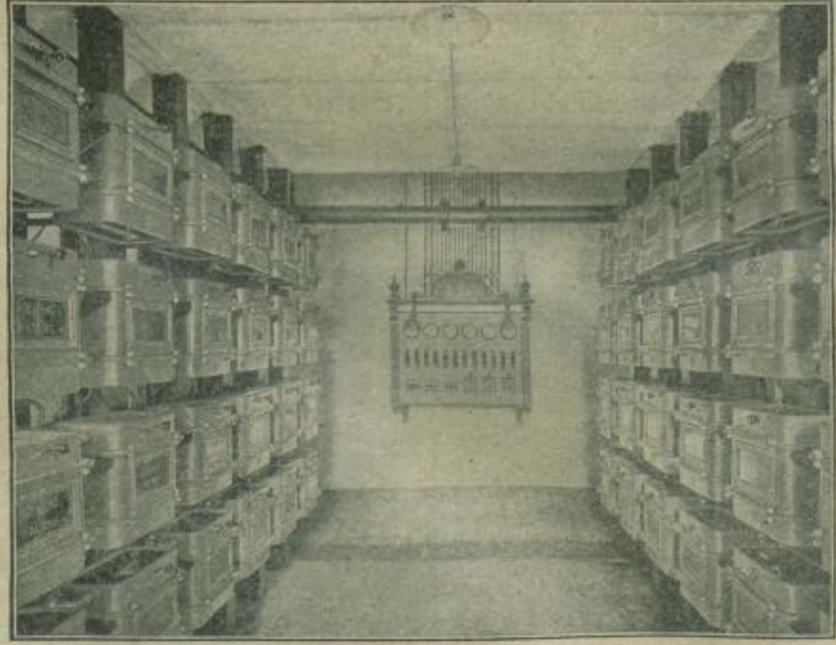
Das neue Wiesbadener Trinkwasserwerk: Ozon-Apparate.
