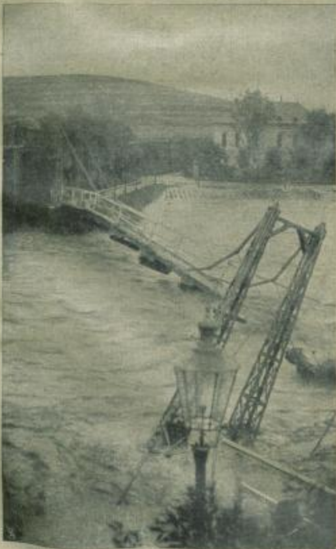
Eingestürzte Brücke über die Viere bei Ziegenhals.
