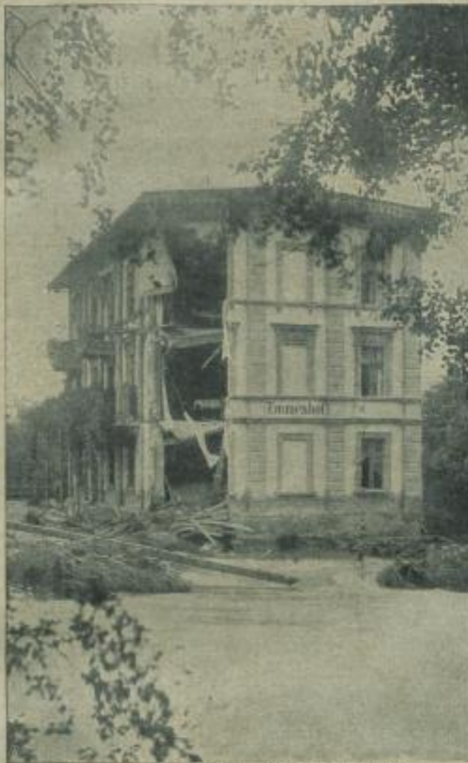
Vom Hochwasser zerstörte Villa in Ziegenhals.
