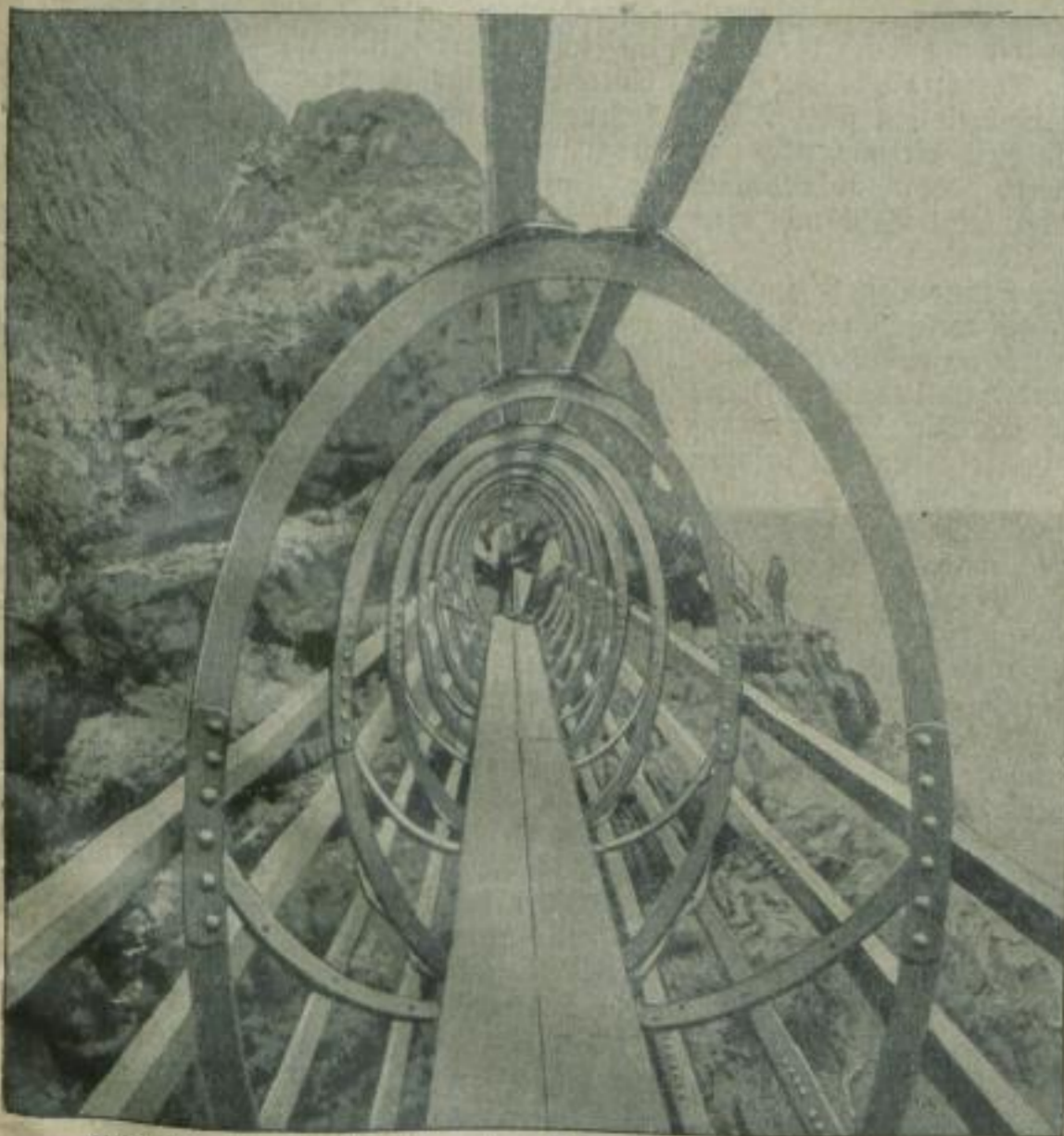
Blick über die Stahlbrücke an den Cabans-Klippen in Nord-Irland.
