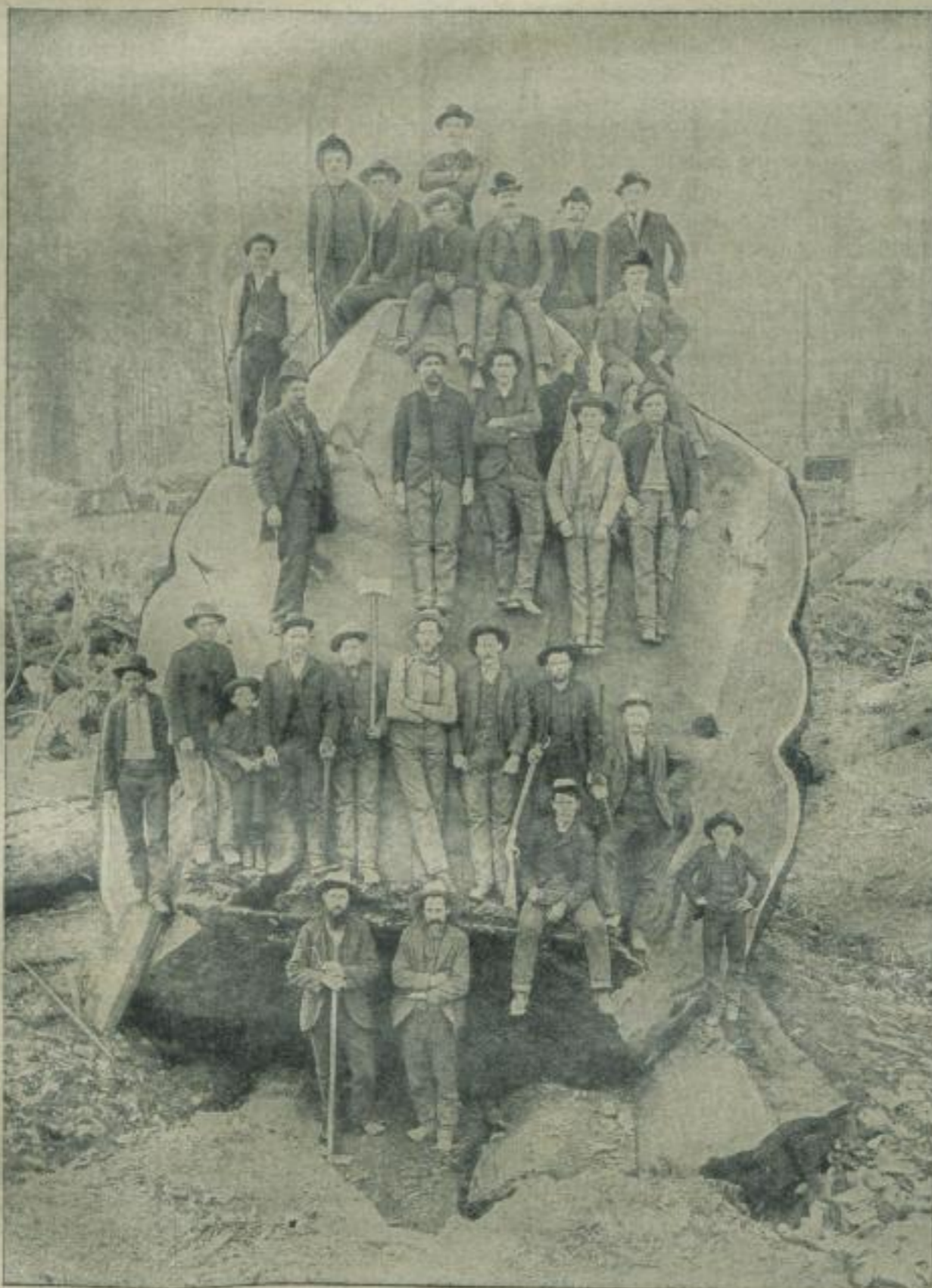
Der Querschnitt des „Mark Twain“ mit der Arbeiterkolonne.
