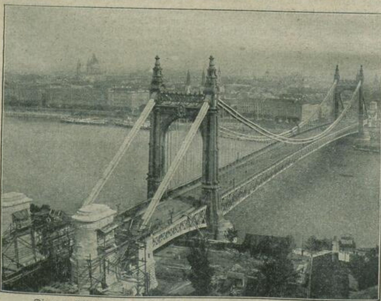
Die neue Elisabethbrücke in Budapest (zur demnächst stattfindenden Eröffnung).
