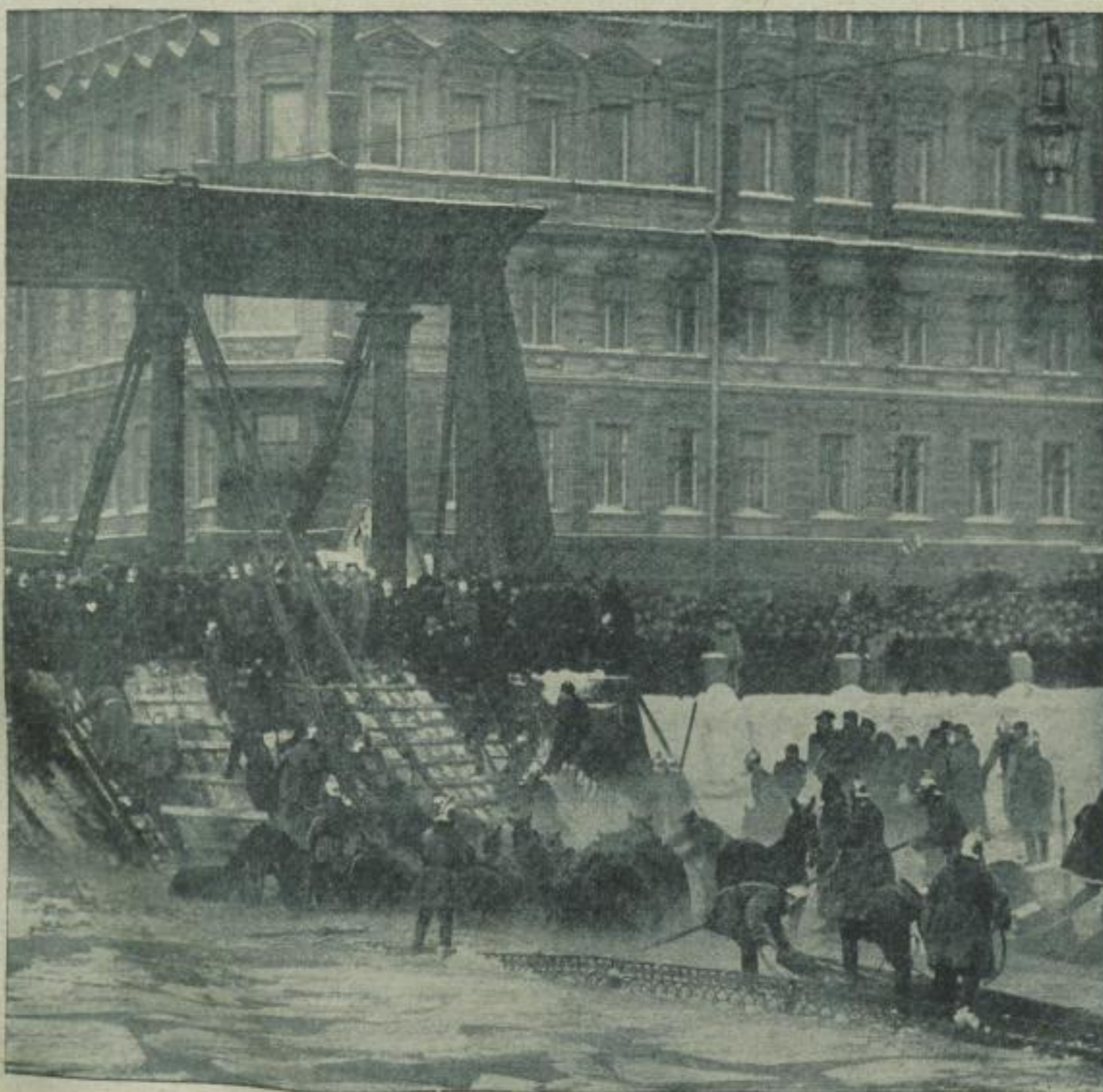
Die Brückenkatastrophe in Petersburg.
