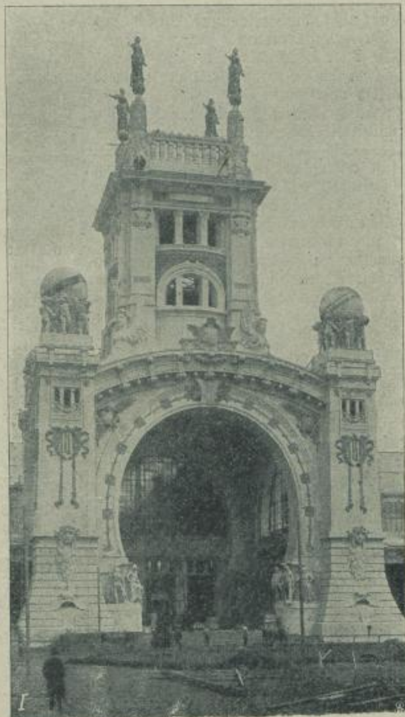
Von der Welt-Ausstellung in Lüttich: Portal des Ausstellungs-Gebäudes.
