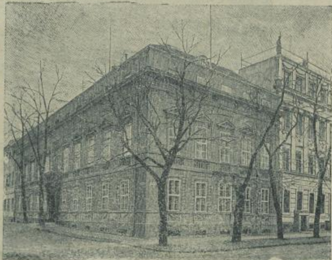
Das Kabinettshaus in Potsdam: Ehemaliges Junggesellenheim des Kronprinzen (Siehe auch nebenstehende Seite.)
