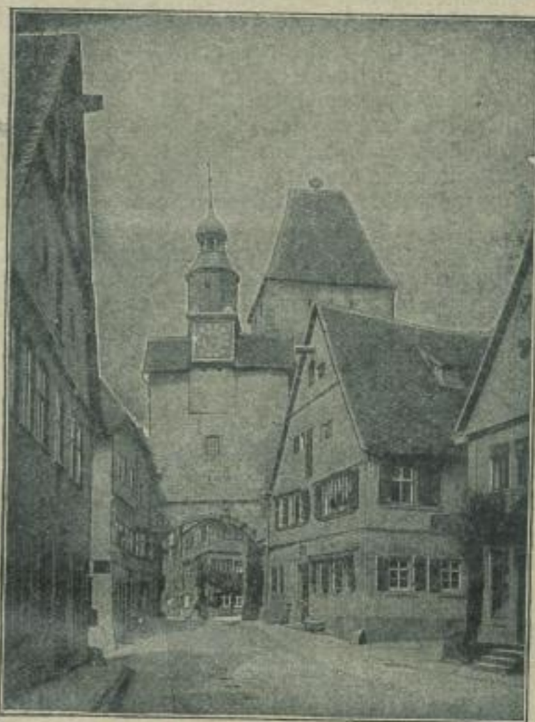
Markusturm und Röderbogen in Rothenburg o. d. T.
