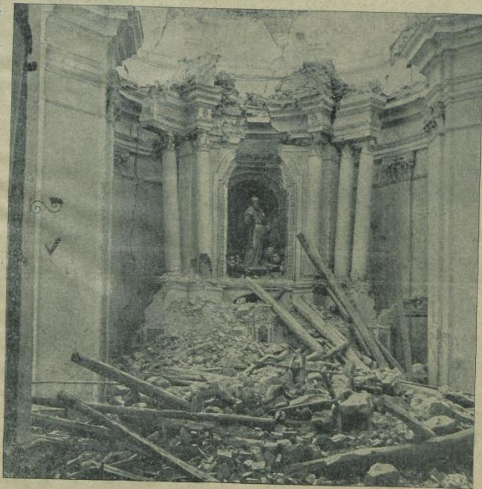
Erdbeben in Kalabrien: Blick in das Innere der zerstörten Kirche.
