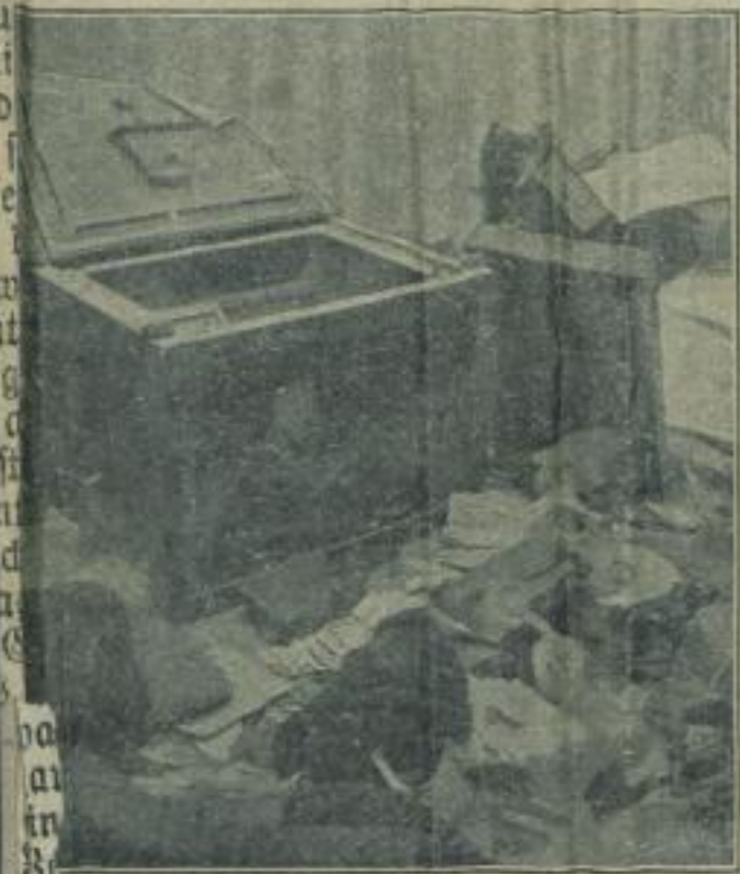
Trümmer eines ausgeraubten Geldschrankes.
