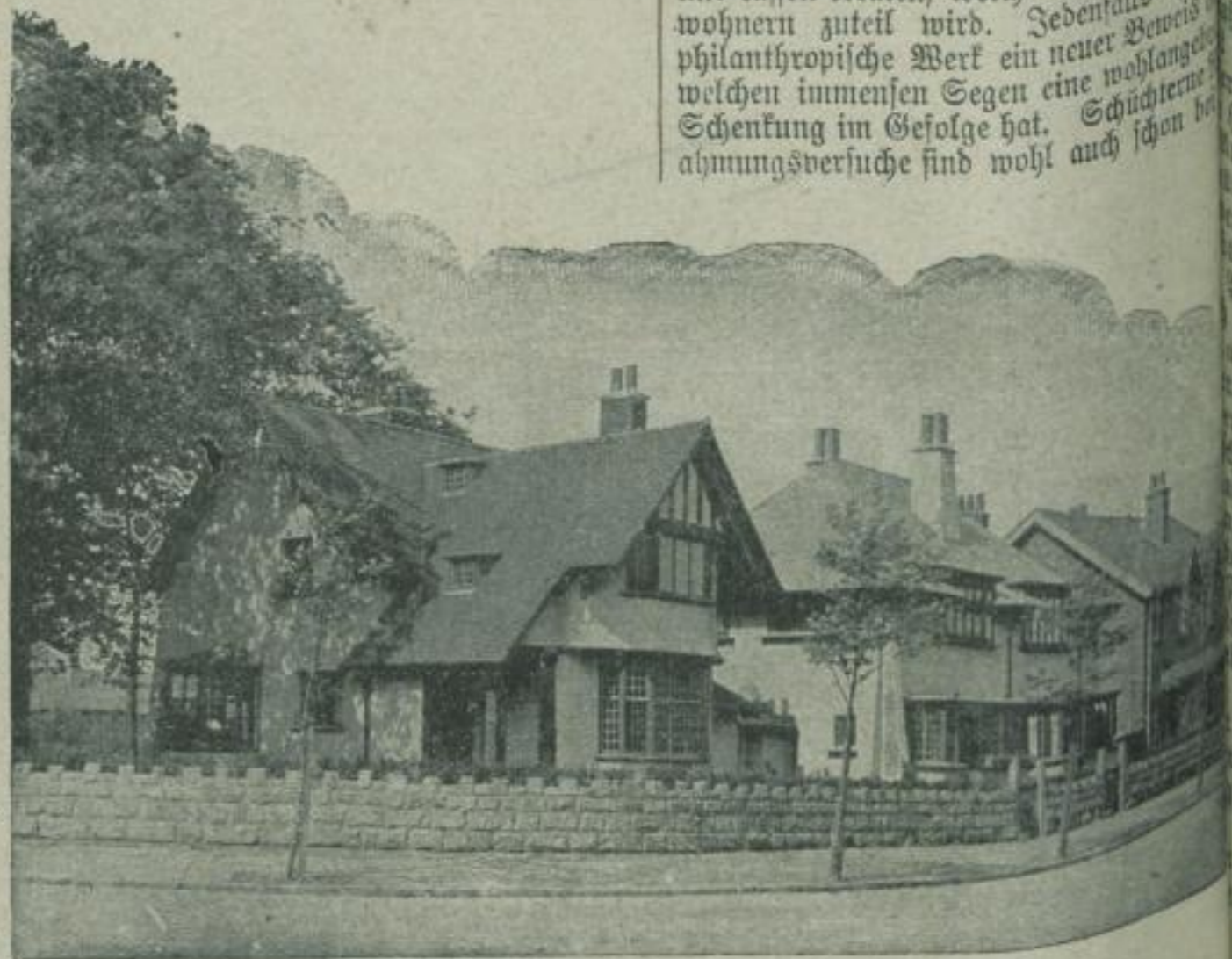
Arbeiterwohnungen mit Landhauscharakter.
