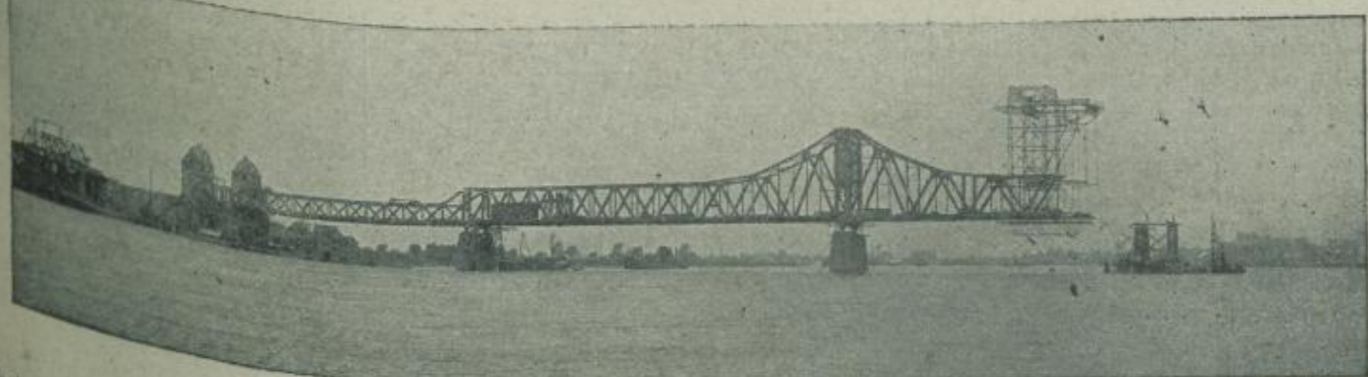
Die neue Rheinbrücke Ruhrort-Homburg im Bau.
