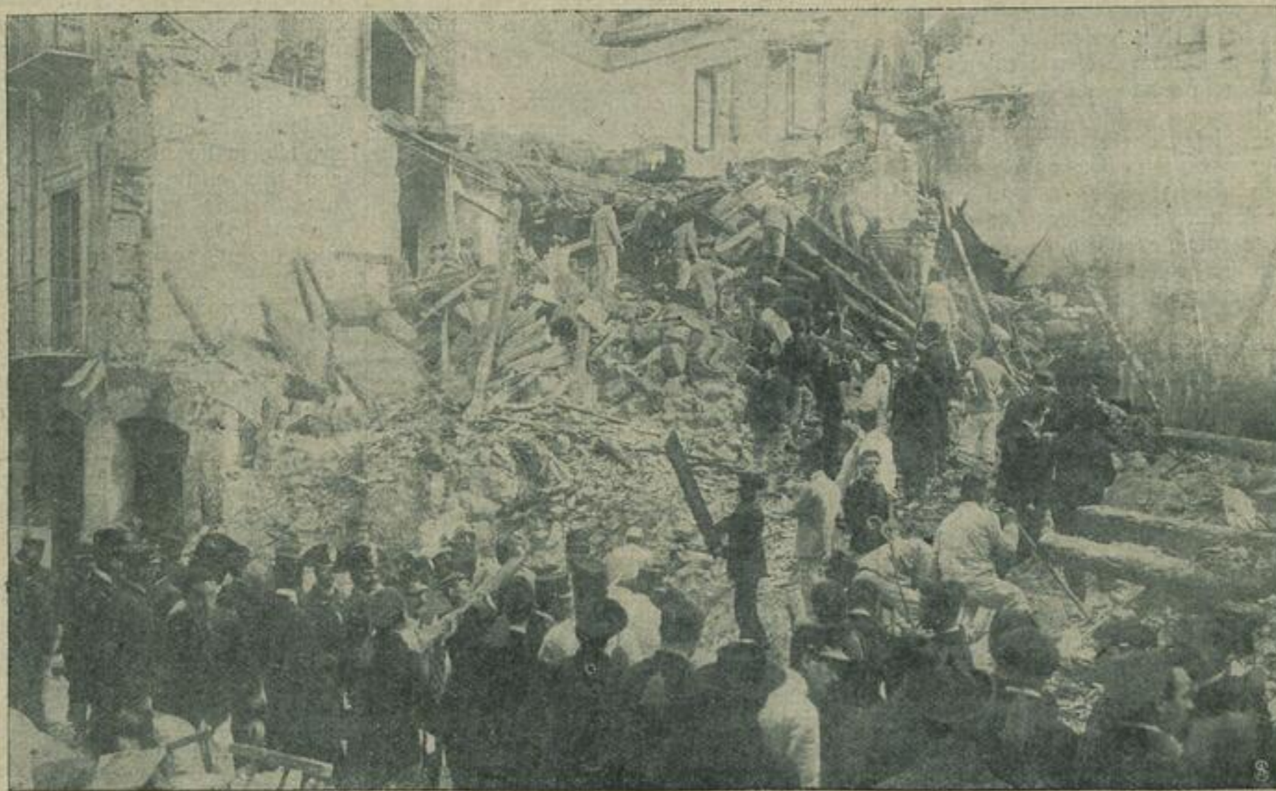
Die Trümmerstätte der Dynamitexplosion in Palermo.
