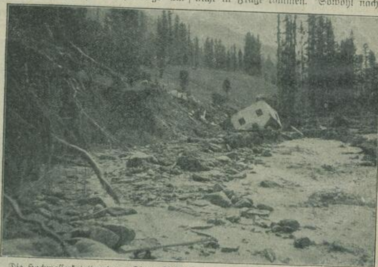
Die Hochwasserkatastrophe in Tirol: Abgestürztes Haus im Alpbachtal bei Brizlegg.
