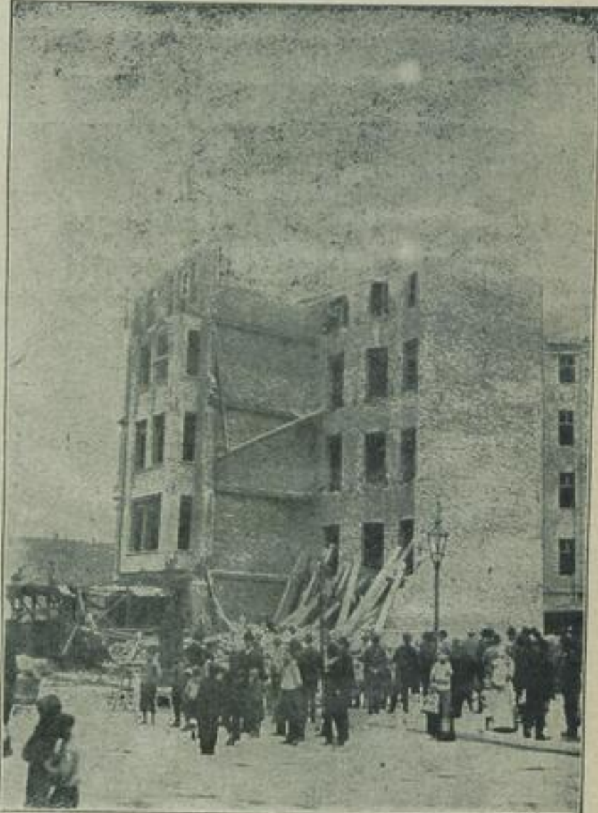
Einsturz eines Neubaus in Charlottenburg.
