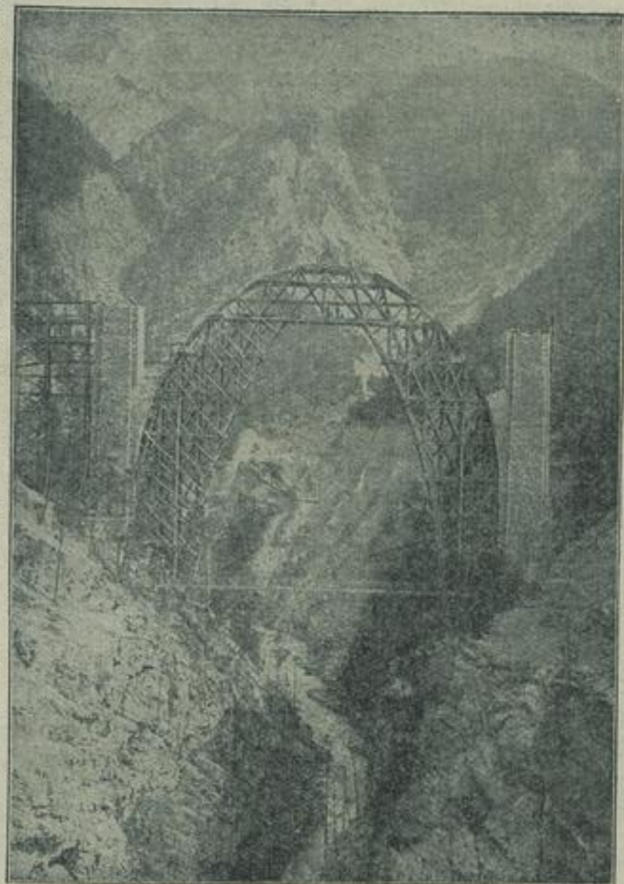
Vom Bau der Bahnlinie Davos-Filisur: Der Wiesener Viadukt.
