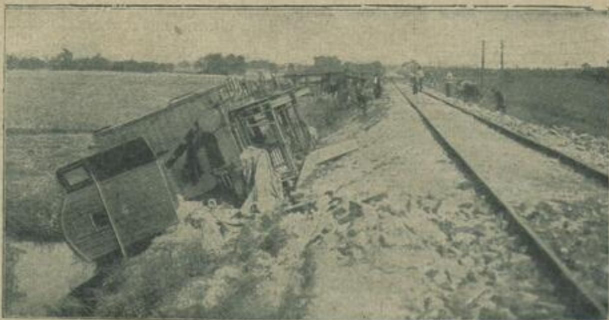
Ein Eisenbahnzug auf der Strecke Oldenburg-Beer, der von einem orkanartigen Sturm aus den Schienen gehoben und umgeworfen wurde.
