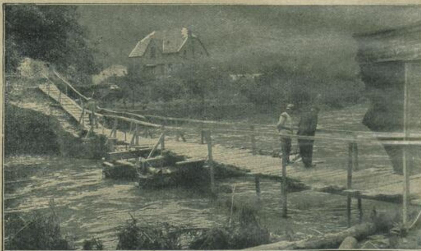
Zur Wasserkatastrophe im Ahrthal. Die Notbrücke an der zerstörten Brücke in Altenahr.
