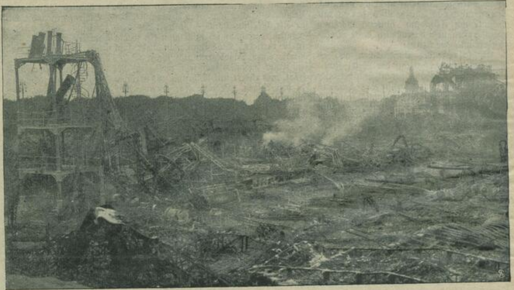
Trümmer der großen belgischen Ausstellungshalle: Blick über den zerstörten Innenraum nach dem Restaurant „Grüner Hund“.
