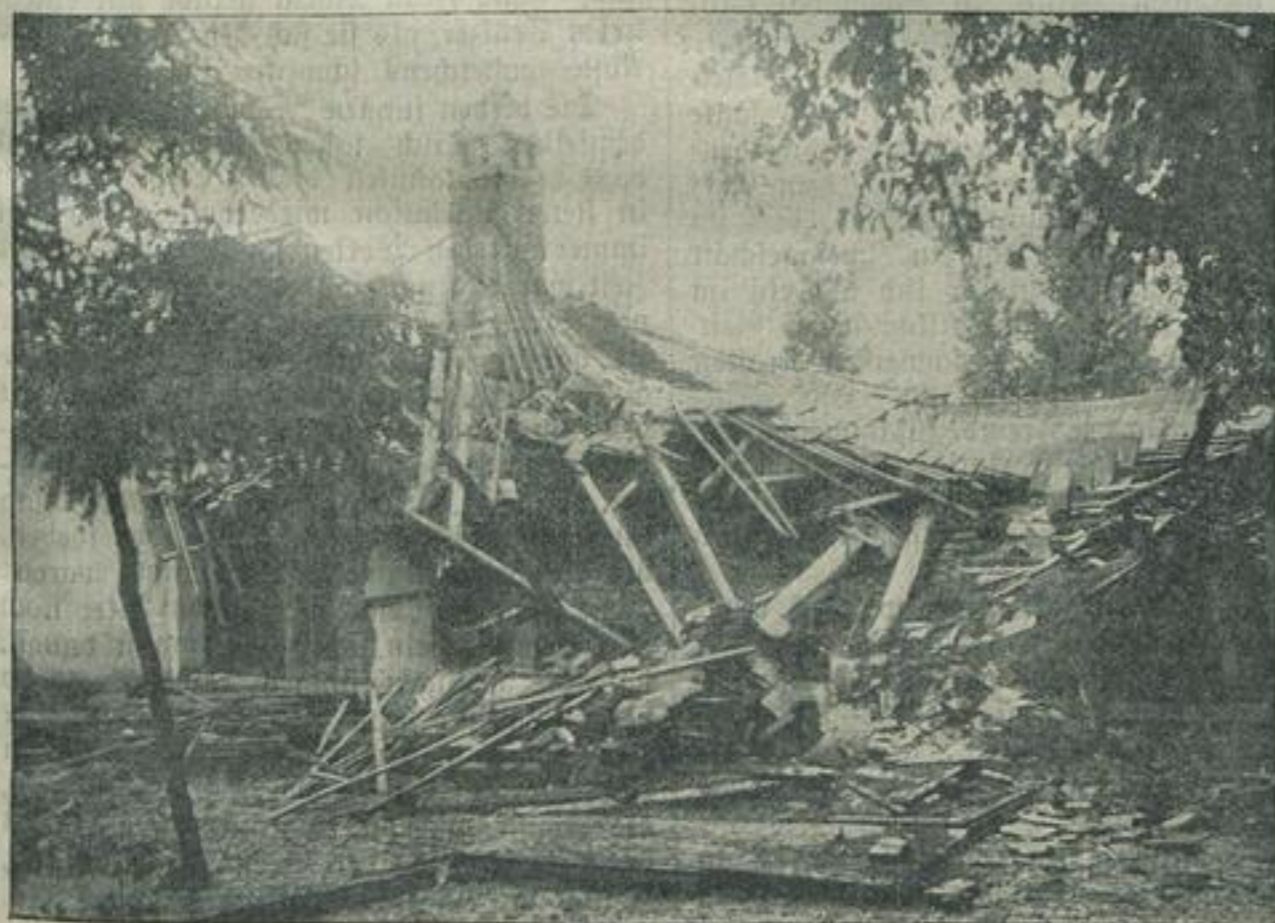
Ein eingestürztes Haus in Kunowitz
