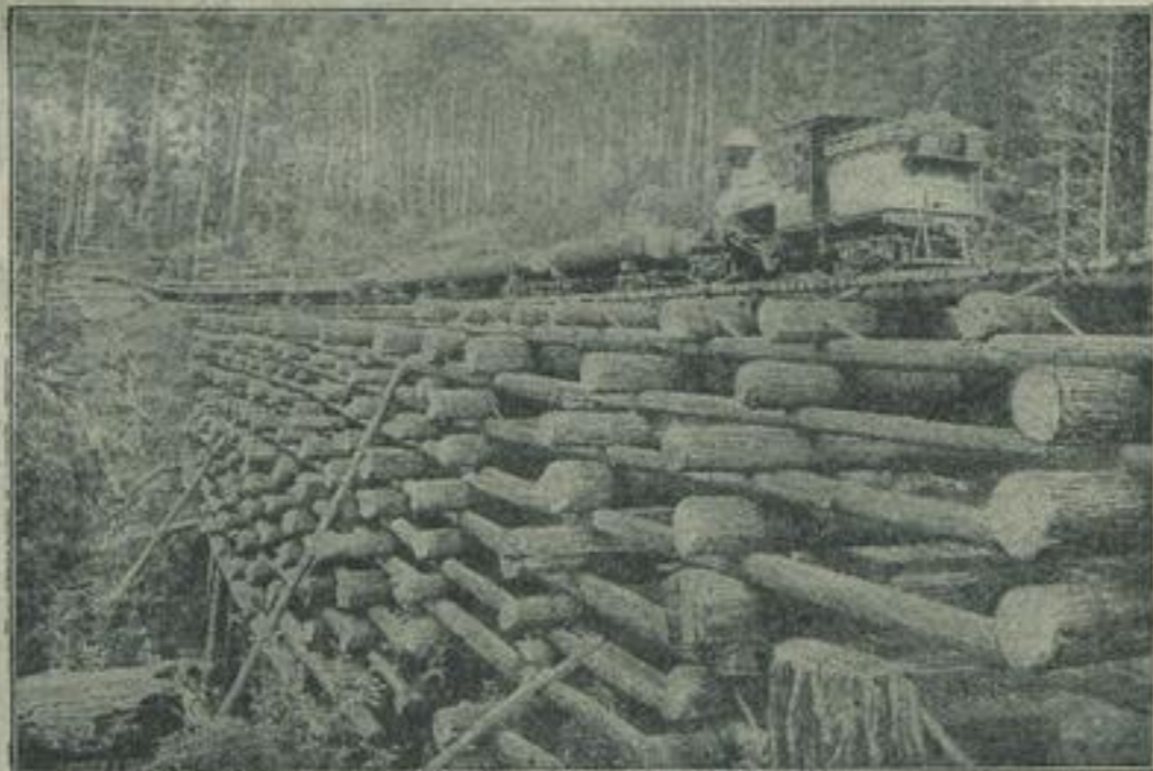
Primitiver Brückenbau auf einer Holzbeförderungsbahnstrecke.
