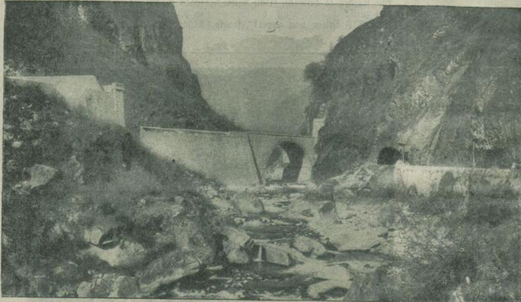
Strasse und Simplonbahnviadukt in der Diveriaschlucht zwischen Iselle und Domodossola.
