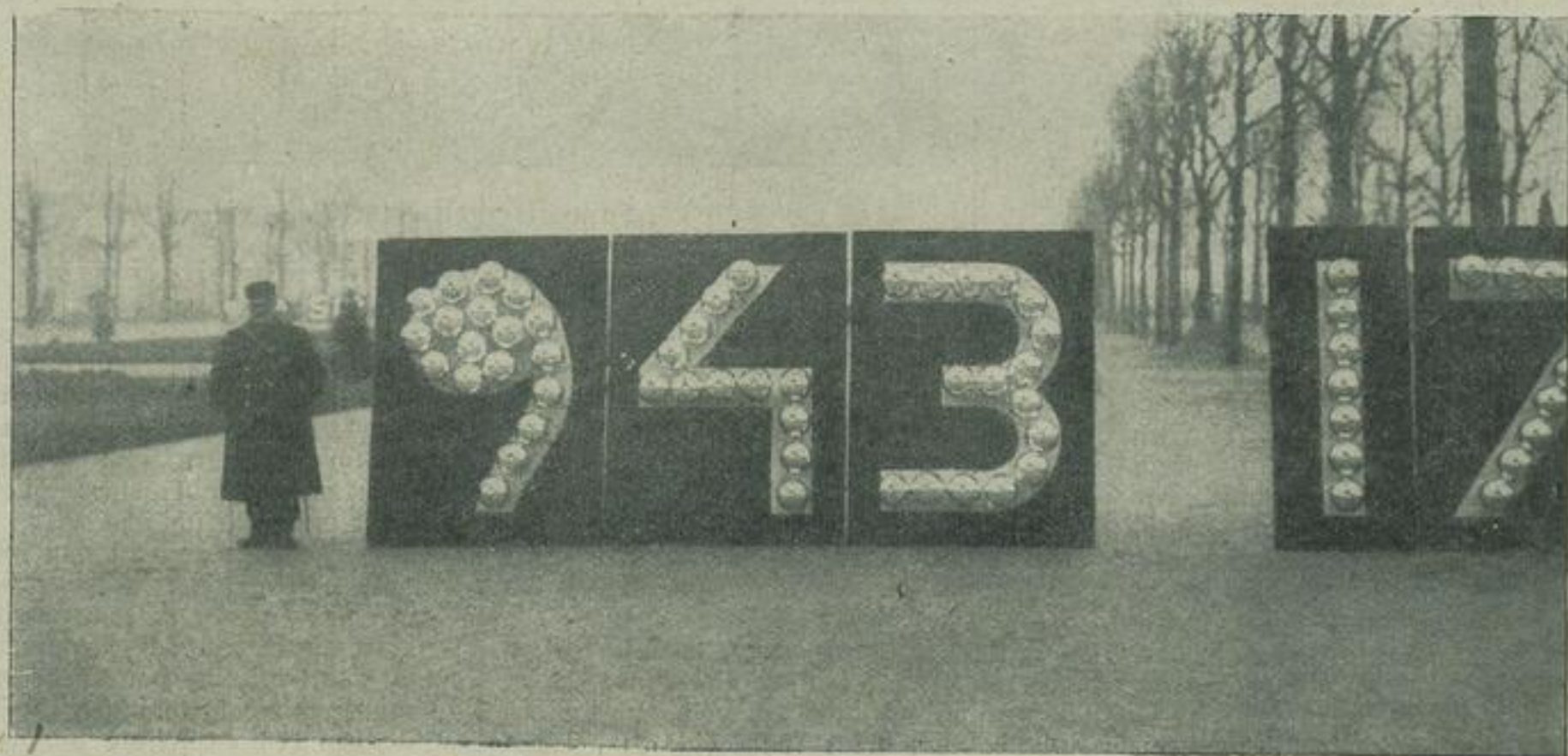
Luftwegweiserzahlen mit Leuchteinrichtung in Frankreich.
