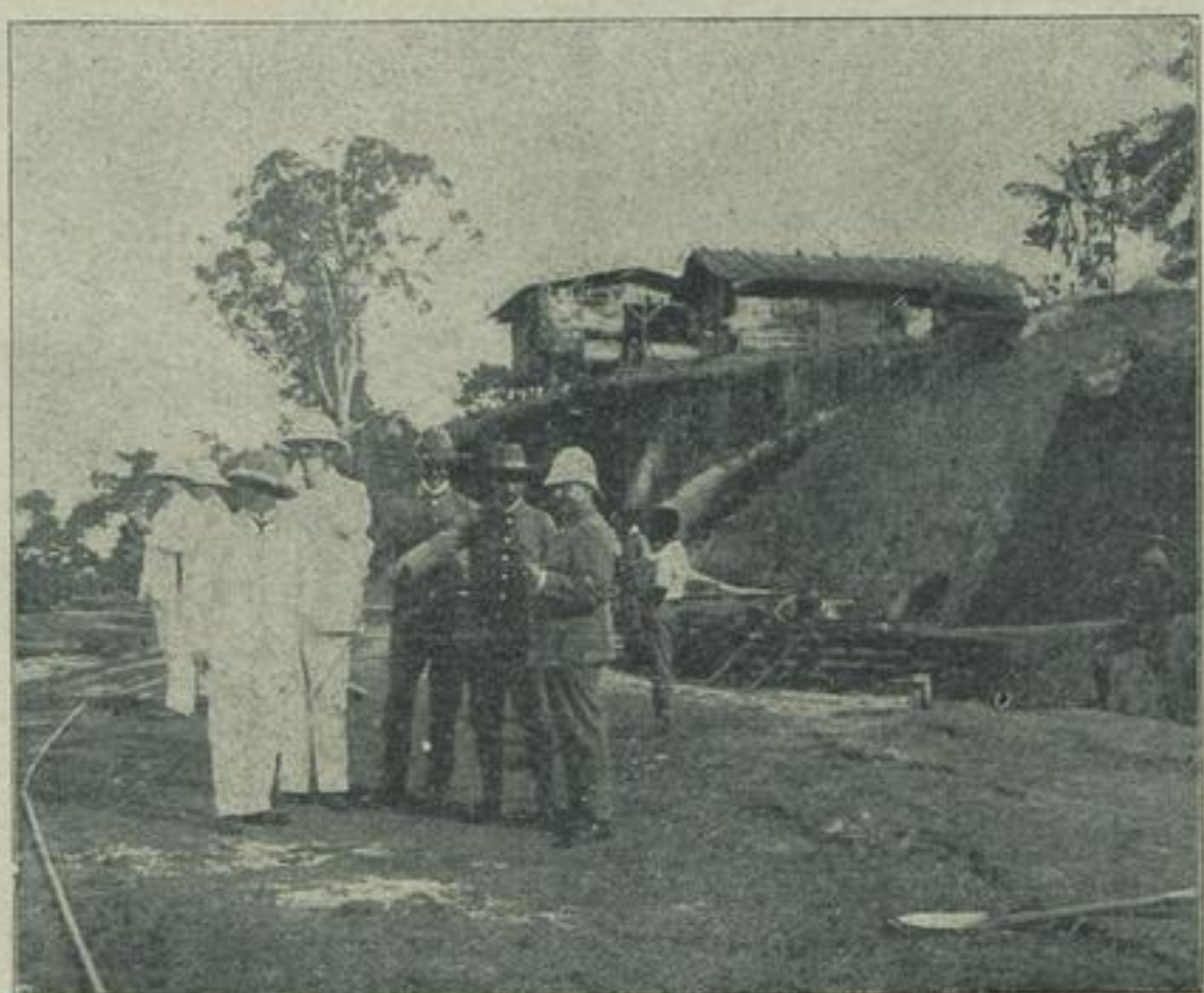
Gouverneur Gleim besichtigt die Baustraße.
