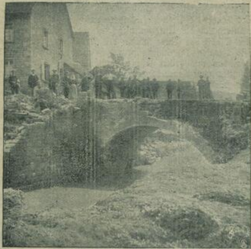
Zerstörte Brücke in Grünsfeld.
