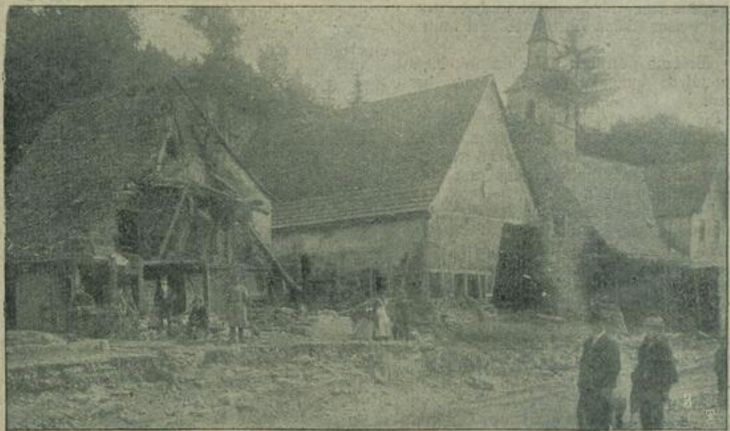
Straße mit verwüsteten Häusern in Paimar
