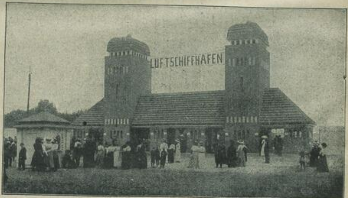
Der Luftschiffhafen in Potsdam.
