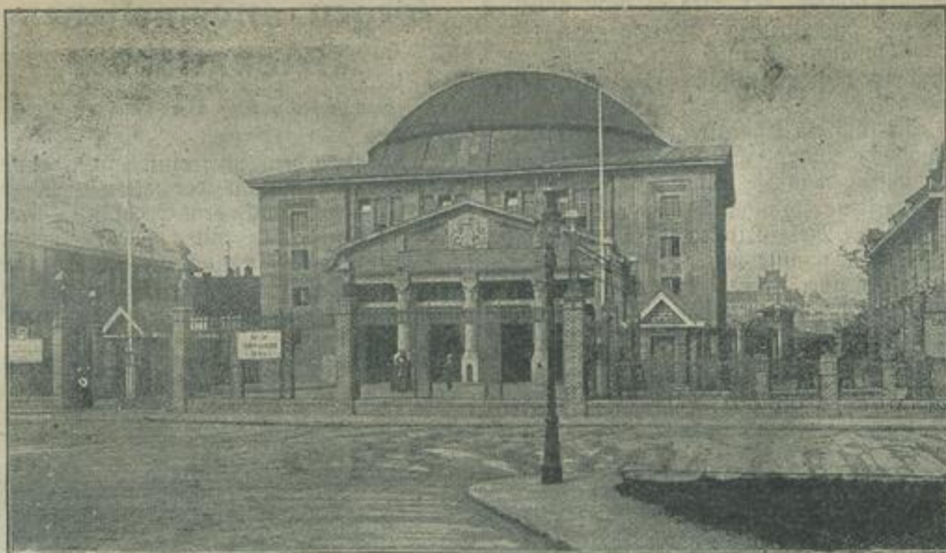
Vom neuen Hamburger Elbtunnel: Das Eingangsgebäude auf der Steinwärder Seite.
