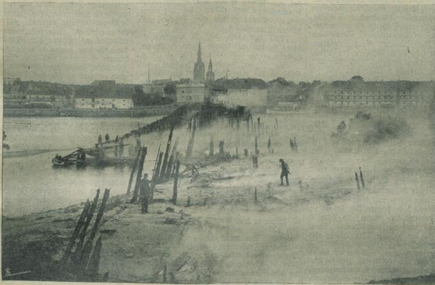
Zum Brand der Oderbrücke bei Schwedt: Die Trümmer der völlig zerstörten Brücke.
