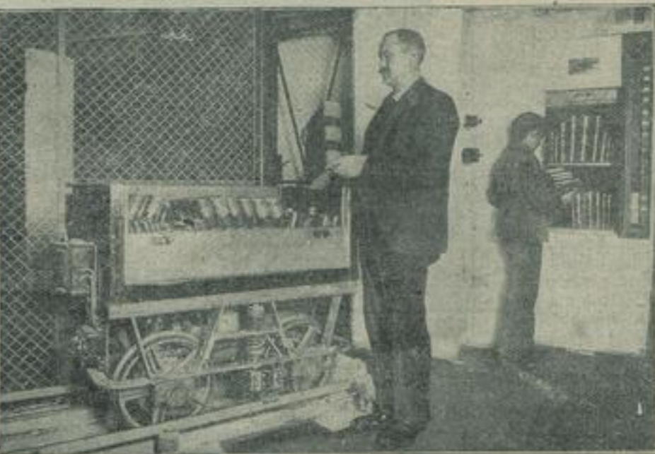
Elektrisch betriebener Büchertransportwagen und Fahrstuhl im Bücherlager.
