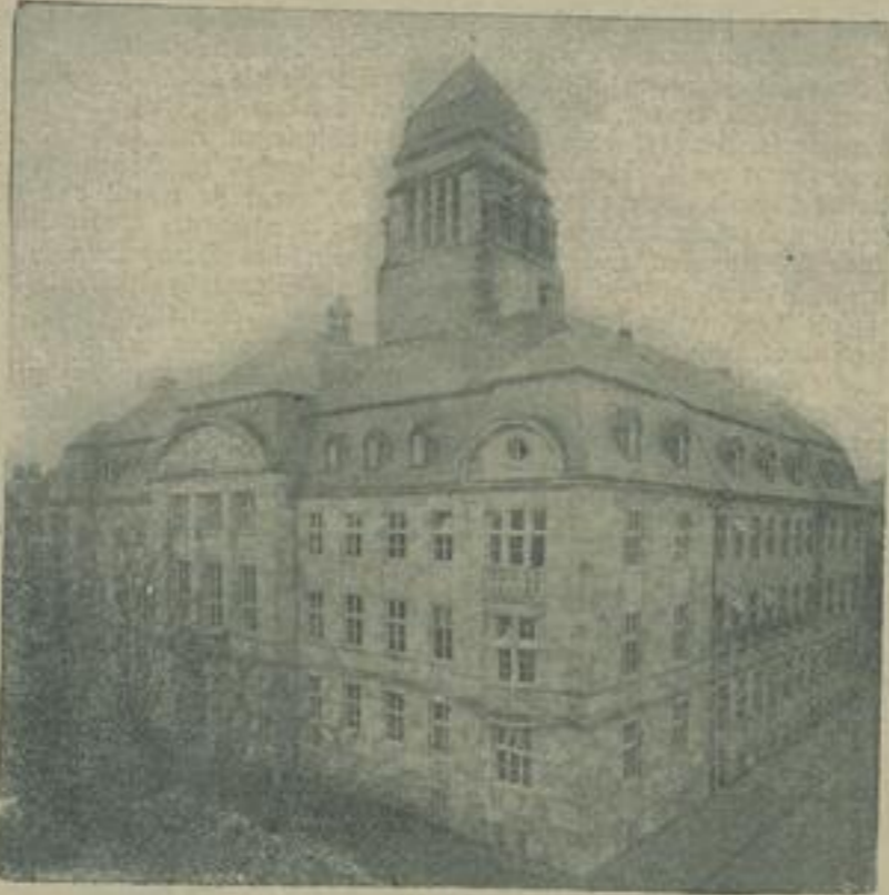
Das neue Regierungsgebäude in Detmold.
