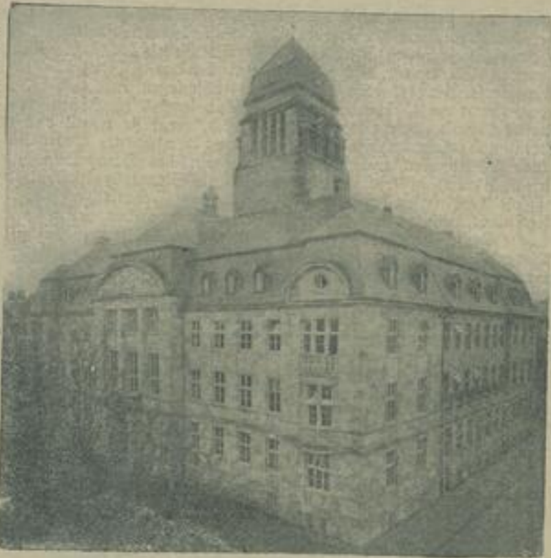
Das neue Regierungsgebäude in Detmold.
