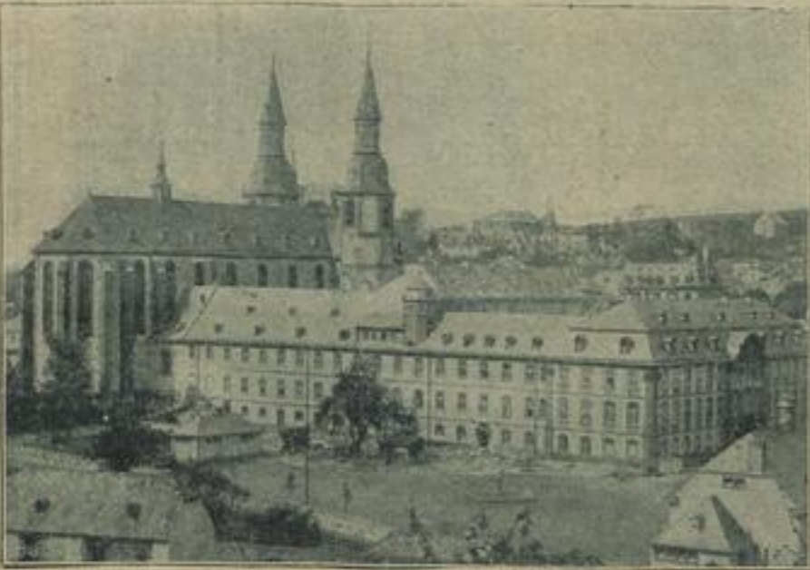
Die renovierte Benediktinerabtei zu Prüm.
