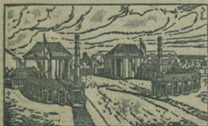
Haupteingang H in der Strasse des 18. Oktober.
