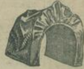
Tunnel, wie Bild . . . . 0.90
