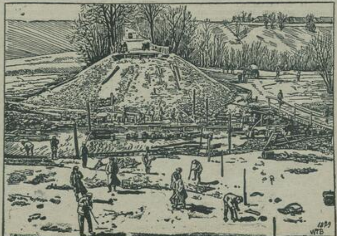
Wiederherstellung der von den Russen verbrannten Chaussee-Brücke bei Skaudville in der Nähe von Libau.
